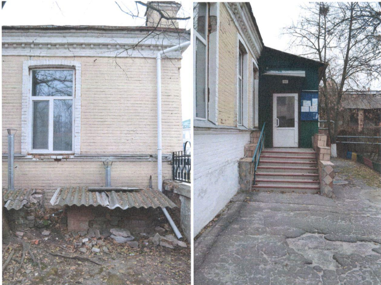
Рис. 2.3 – Руйнування вимоцнення та прямиків
