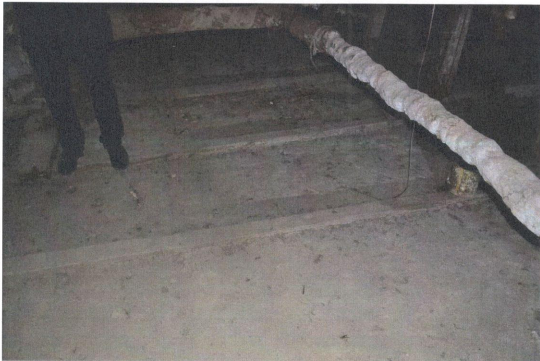
Рис. 1.7 – Загальний вигляд горища
