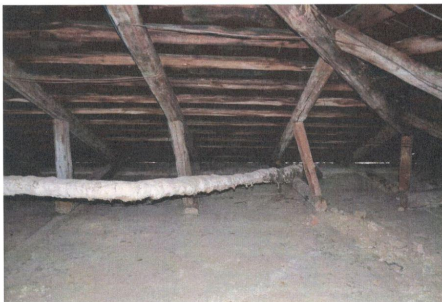
Рис. 2.10 – Непроєктний ухил стійок-підпорок крокв
