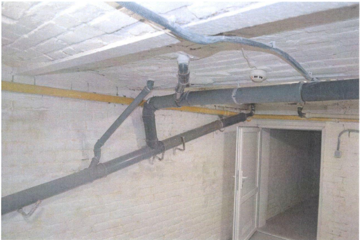
Рис. 1.5 – Загальний вигляд надпідвального перекриття
