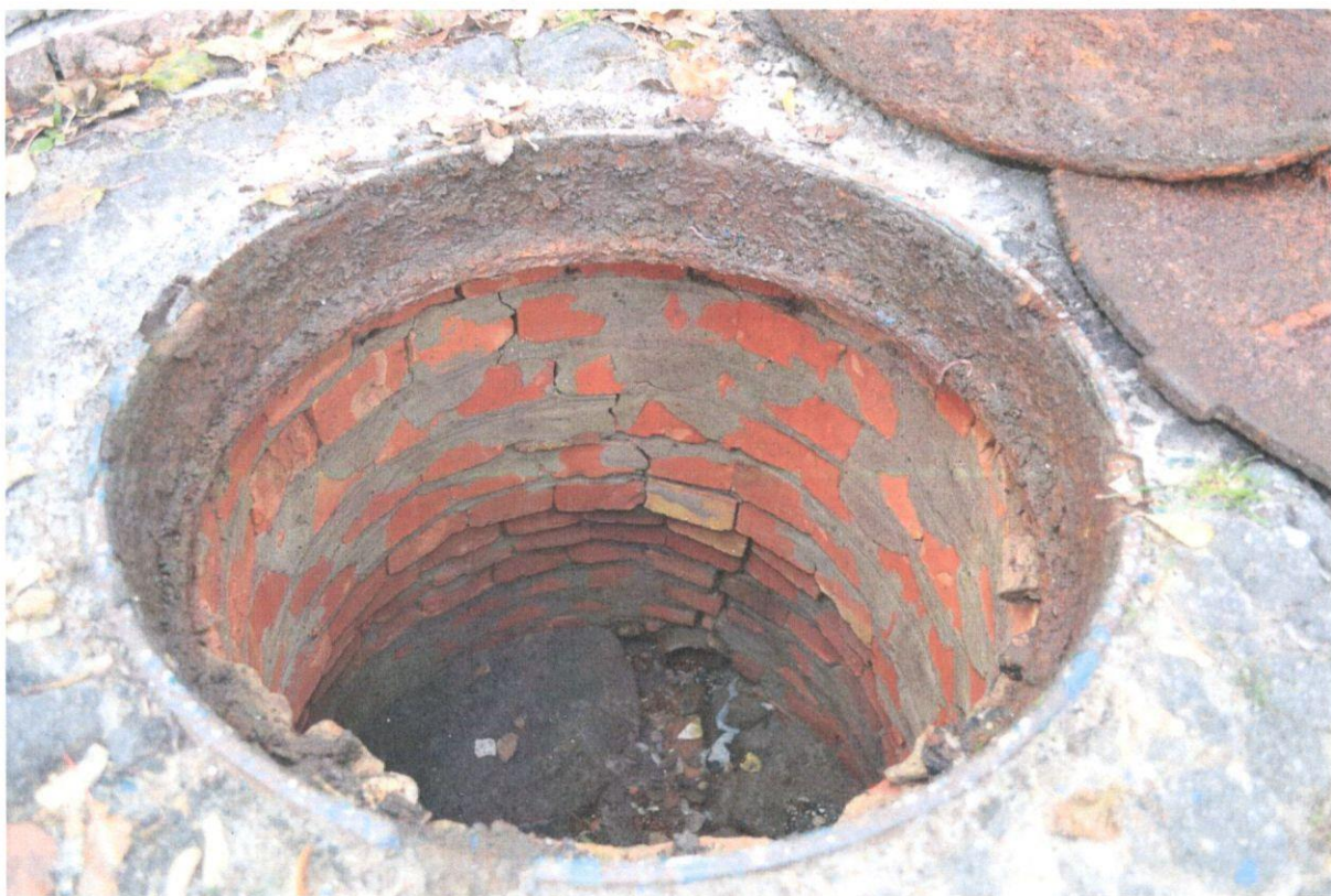
Рис. 2.2 – Загальний вигляд каналізаційних колодязів
