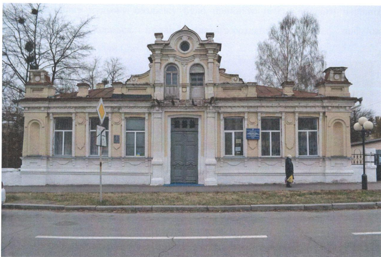
Рис. 1.2– Загальний вигляд будівлі в осях 1-5
