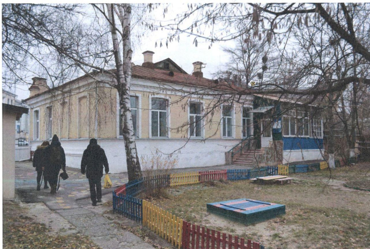
Рис. 1.2– Загальний вигляд будівлі в осях 5-1, Г-А
